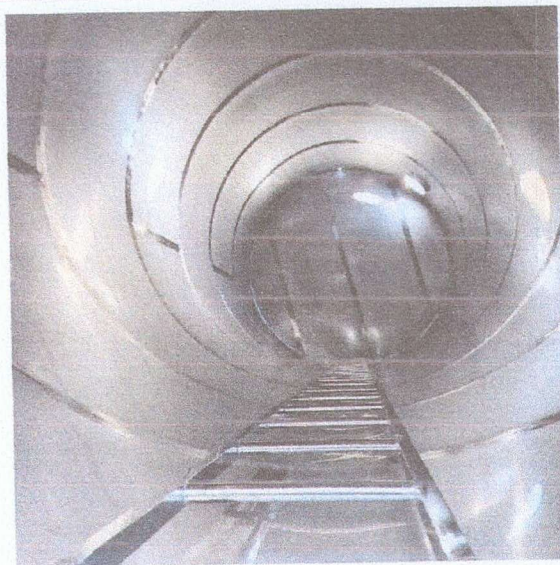
Imagem 1 – Inspeção Visual da solda e acabamentos internos do Reservatório 01
