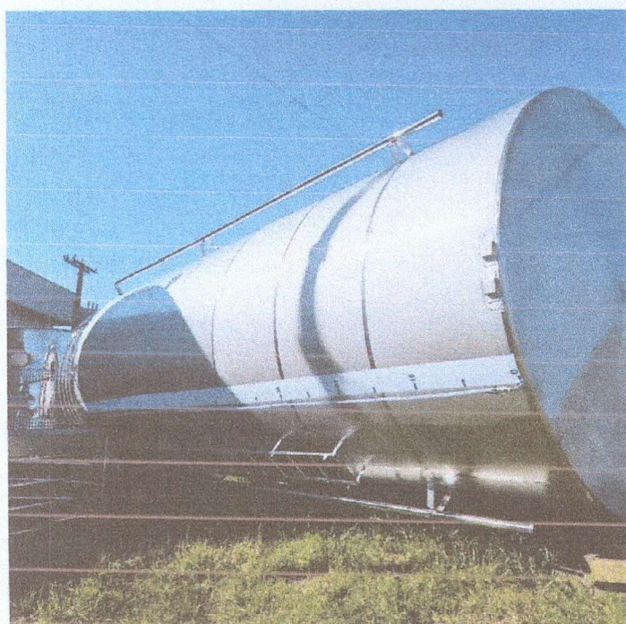
Imagem 5 – Visual Lateral Reservatório 02
