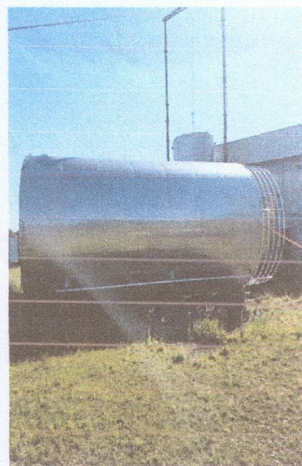
Imagem 4 – Visual Lateral tanque 01
